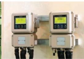
测量冷水和冷却液流量的山武MagneW™ 3000电磁流量计
