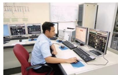
安装在监控室中的Harmonas-DEO对装置中的制冷机及其他设备进行中央监控
