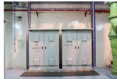
安装在装置内的新控制盘，盘内设有各种控制制冷机、水泵和其它设备的控制器。
