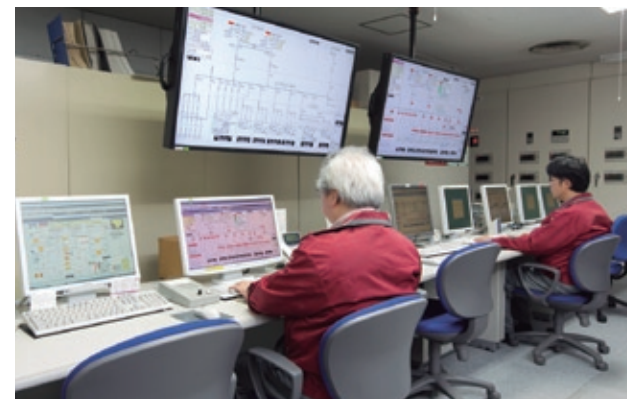
安装在Sunpiaza中央监视室中的BEMS、阿自倍尔的楼宇管理系统savic-net™FX。与安装在dUo的中央监视室中的BEMS之间可以相互监视。
