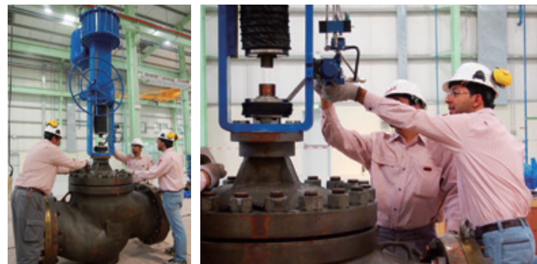
正在安装大口径阀门的Azbil Saudi Limited的员工。
