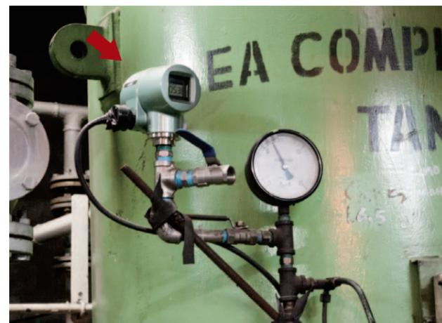
压缩机制造的压缩空气被临时储存在空气缓冲罐中。通过压力传感器Bravolight™测量罐中压力，根据生产线的需求量进行压缩机的台数控制。
