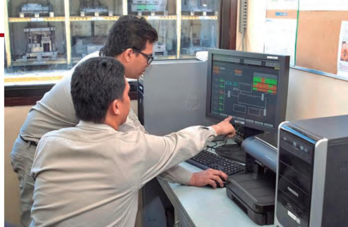
安装在中央监控室内的Harmonas-DEO的画面。监视从压缩机向生产现场所供给气体的消耗量、压力等，并根据监视结果进行设备的台数控制。
