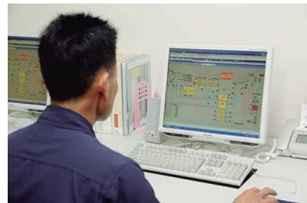
安装在中央监控室内的savic-net FX。
