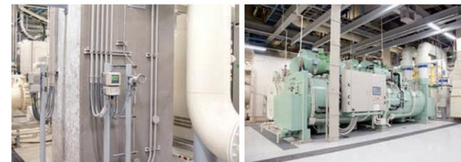
利用电力制造冷水的涡轮冷冻机。计量其流量的电磁流量计 MagneW™3000 FLEX\*和计量压力的DSTJ3000 Ace\*。
