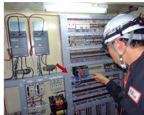
编制符合修订后的JIS标准的程序,进行燃烧安全控制的烧嘴控制器。
