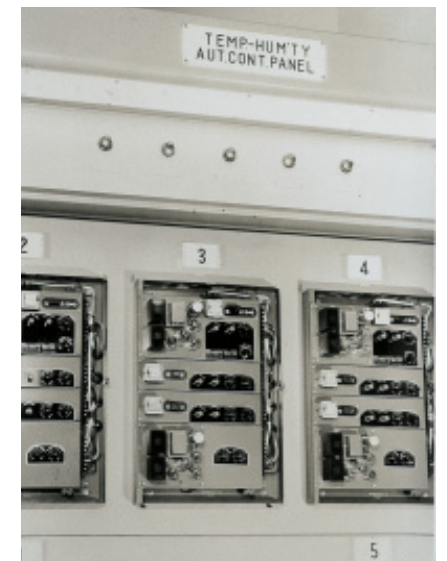
横田空軍基地の空調制御パネル
