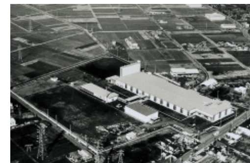
調節弁専門工場としてスタートした寒川工場
