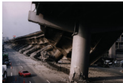
阪神・淡路大震災で崩れ落ちた阪神高速神戸線
