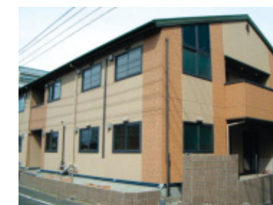
山武ケアネット (YCN) の運営するグループホーム
