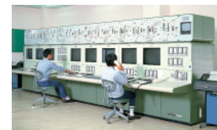
石油精製装置の総合制御システム（TDCSとセミグラフィック併用監視制御盤、当時の丸善石油・千葉精油所）
