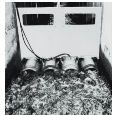
潜水電磁流量計MagneW-Kシリーズ
