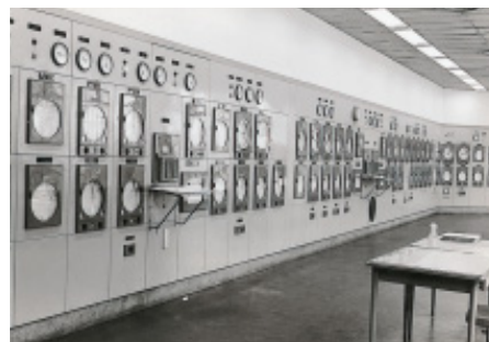
角型計器による大規模計装盤 (石油精製装置)
