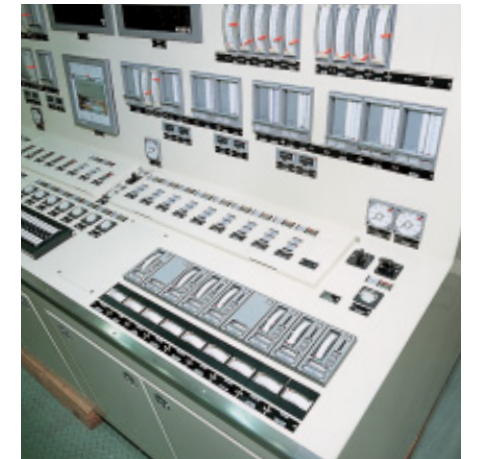
JAシステム計装パネル
