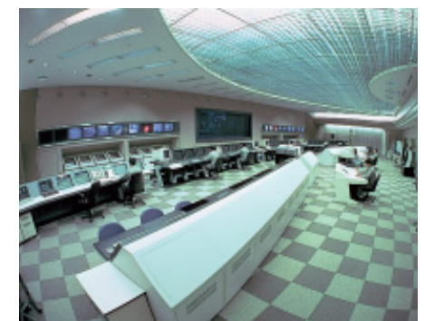
TDCS3000LCNによる中央制御室 （出光興産・北海道製油所）
