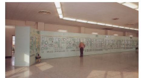
ETOSによるフルグラフィックパネル
