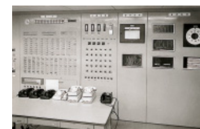
ホテルに導入された空調監視盤
