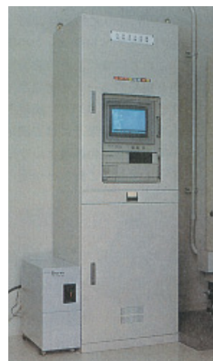
空調制御の他に水系消火設備の自動点検システムも納入（弊社PR誌より）
