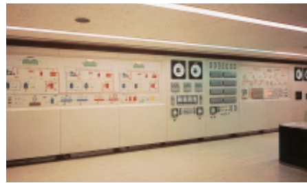
千里中央エネルギーセンター
