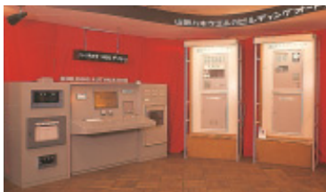
グラフィックパネルによるセレクトコードシステム空調制御盤
