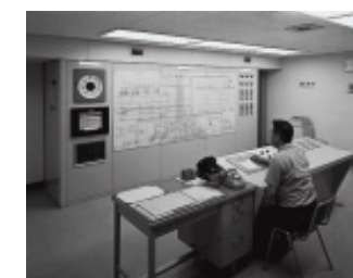
中央監視室の空調制御盤
