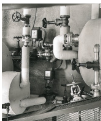
モジュトロールモータ付空調バルブ
