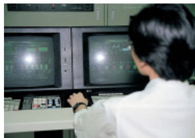
地域冷暖房の熱供給設備／監視室
