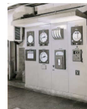
工業計器の熱源監視盤
