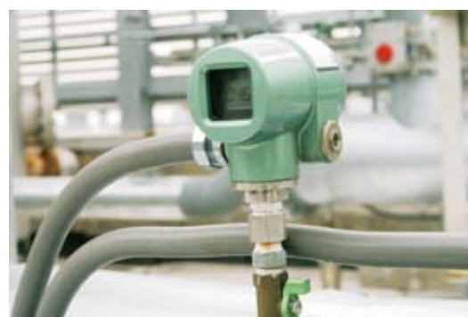
エア、蒸気の圧力センシングには、山武の圧力センサBravolightが使用されています
