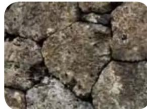
石垣の積み方は、「あいかた積み」と呼ばれる沖縄独自のもの。5角形や6角形など多面体の岩を積み、すき間に小石を詰めて組む。面が多いことで力が加わっても多方向に分散され、衝撃に強い。
