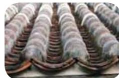
沖縄ではスコールのような激しい雨が降った後、カラッと晴れることが多い。そのため、瓦はある程度水が染み込むように素焼きのままにし、太陽の熱で水分が蒸発する時に屋根裏の熱を奪い、涼しくするようにしている。
