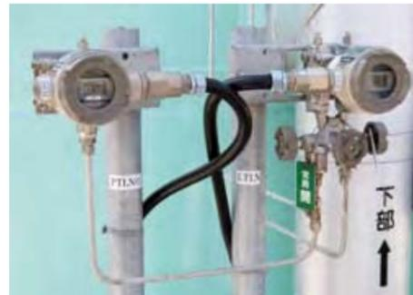
タンク内の天然ガス量を計測する差圧・圧力発信器 DSTJ3000™。液面測定（右）と圧力測定（左）
