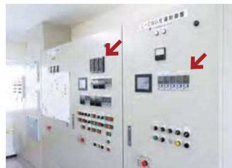
プログラマブルコントローラや、シングループコントローラなどが並ぶ LNG サテライト制御盤とL-CNG 充填制御盤
