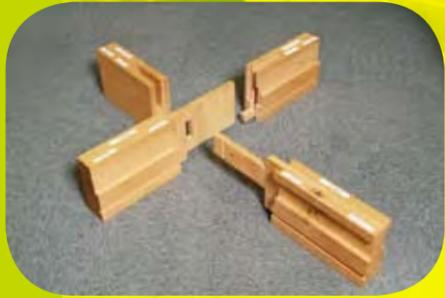
水平材・垂直材・斜材の部材を組み合わせるときの接合部分を仕口という。この仕口部分の凸型をほぞ、ほぞが入る凹をほぞ穴といい、さまざまな形がある
