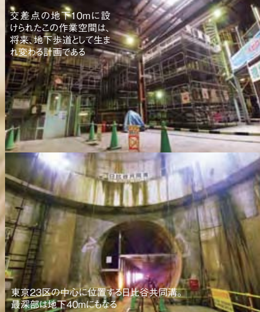
日比谷共同溝では、シールド工法で約1.5kmのトンネルを掘削した。トンネルが貫通した場所での誤差は上下2mmであった
