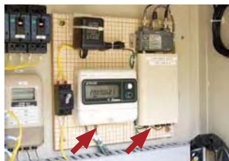
金門製作所のデマンド計KFH-300とロードサーベイト伝送端末機器により、CMPで計測したデータを、データ通信網を利用して配信できる
