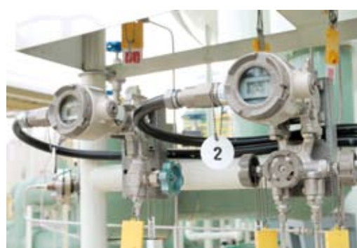
液面(右)と圧力(左)を計測する差圧／圧力発信器 DSTJ™3000
