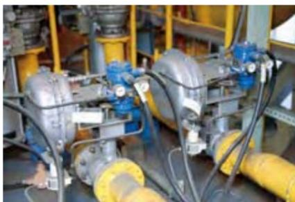
燃焼プロセスで使用されている調節弁とValstaff対応のポジションナ
