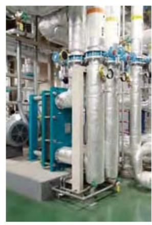
コージェネレーション排熱回収用温水熱交換器
