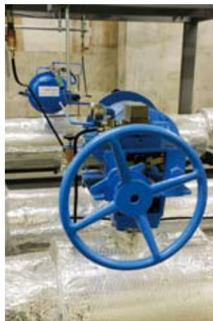
供給先ビルの熱源受入設備に設置されたFloWing（フローウィング）偏心軸回転調節弁（VFR）
