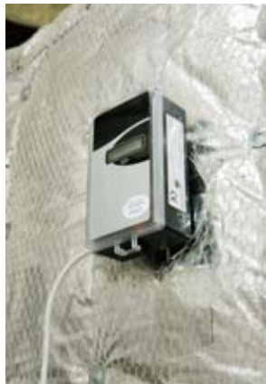
CO 2 濃度発信器CY-8000。テナントの各部屋から戻る還気のCO 2 量を計測し、外気の取り入れ量を定める
