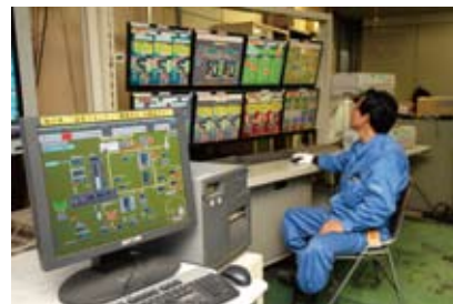
廃熱回収ボイラと分塊均熱炉を制御するHarmonasディスプレイ群
