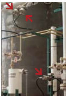
設置されたDSTJ3000Ace + リモートシール形発信器。DSTJ本体から導圧管の代わりに黒いチューブが伸びキャピラリに接続
