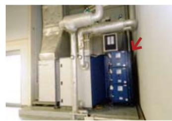
工場1階の3カ所の空調機吸い込み口にTRIONオイルミストコレクターを設置
