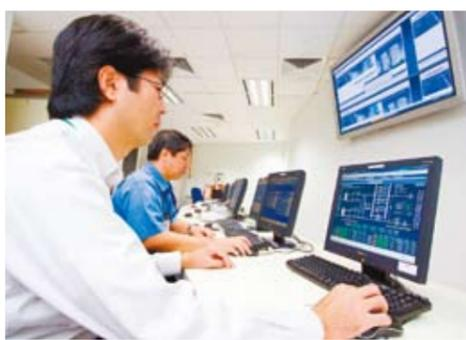
ビルマネジメントシステムとして導入された savic-net FX。電気・空調・防災・防犯・駐車場管理・エレベータなどの監視を集約した統合監視システムとなっている。冷却プラントからの受入れ状態を分かりやすいグラフィックで表示。
