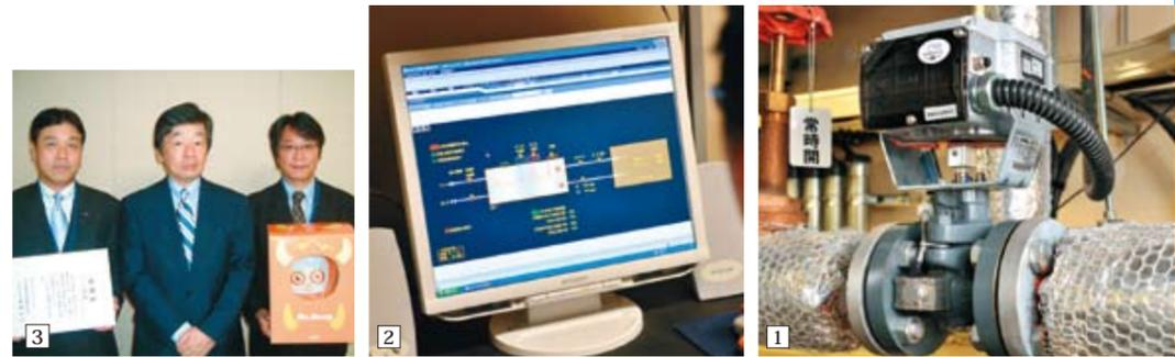
1 流量計測制御機能付電動バルブACTIVAL。各フロアに設置された空調機ごとの冷水/温水の流量を計測することで、実際に必要な量だけの冷水/温水を作る、自動制御の要となる機器。
