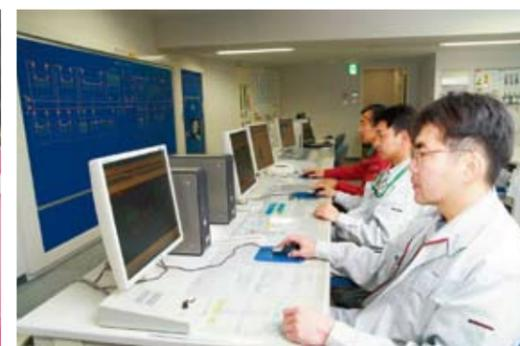
防災センターに設置されたsavic-net FXの監視・制御用端末。国際医療センターをはじめキャンパスにある10棟の建物の設備をここで集中管理している。
