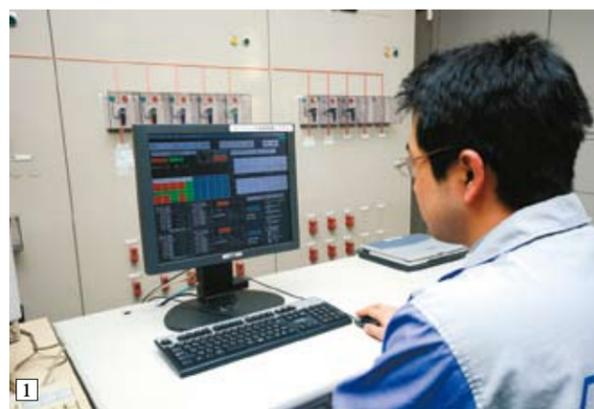
1 事務所内に設置されたHarmonasの監視端末。各コンプレッサの稼働状況やエアの流量、圧力などの情報を事務所に居ながらして確認できる。
