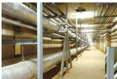
エネルギーセンターと病棟の間に設置された共同溝(約200m)。電気、冷水、蒸気、医療ガスなどを病院棟へ搬送している。配管のつなぎ目からの熱のロスを低減するため、蒸気配管のつなぎ目部分に装着された断熱ジャケット(右)。
