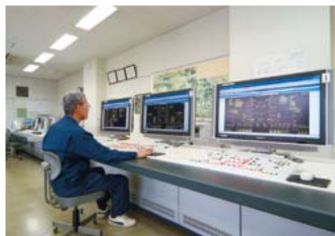
エネルギーセンターのオフィスに設置されたBEMS (savic-net FX)。
