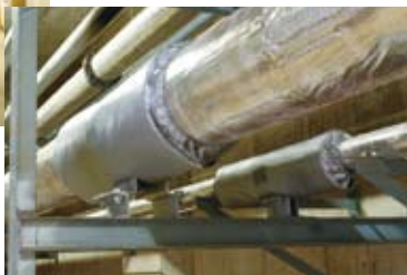
エネルギーセンターと病棟の間に設置された共同溝(約200m)。電気、冷水、蒸気、医療ガスなどを病院棟へ搬送している。配管のつなぎ目からの熱のロスを低減するため、蒸気配管のつなぎ目部分に装着された断熱ジャケット(右)。
