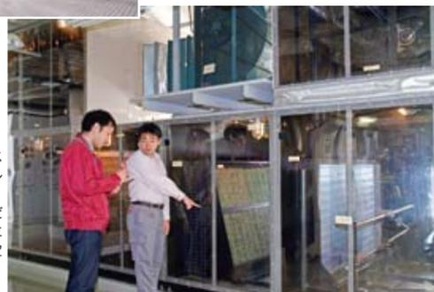
通常は、内部が見えない空調機をスケルトンにし、内部の巻取りフィルタ、中性能フィルタ、冷温水コイル、蒸気コイル、加湿器などの機器がどのように配置されているか、どのように動くのかを、実際に作動している空調機で確認できる。(BSC湘南研修センター)
