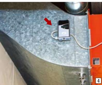
4 施設内からの選りダクトに設置されたCO<sub>2</sub>センサ。計測したCO<sub>2</sub>の量から、空調効率が最もよくなる外気導入量を判断して空調機を制御する。
