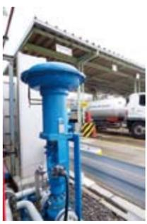
近隣の工場にパイプラインで液化窒素を搬送するためのバルブ。信頼と実績のある山武のトップガイド形単座調節弁 HTS が使われている。
