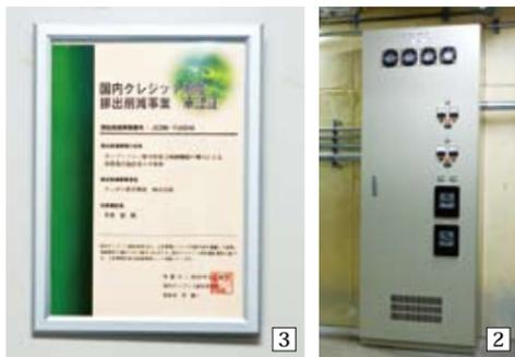
1 中央監視装置をsavic-net FXに更新したことにより操作性が向上。各設備の運用データを集中管理・分析し、施設内の全体最適を目指す。空調機の傍らに設置されたインバータ盤。既存の空調機にインバータを付加することで、空調の負荷状況に応じたファンの回転数制御を行い、電力量を削減する。
