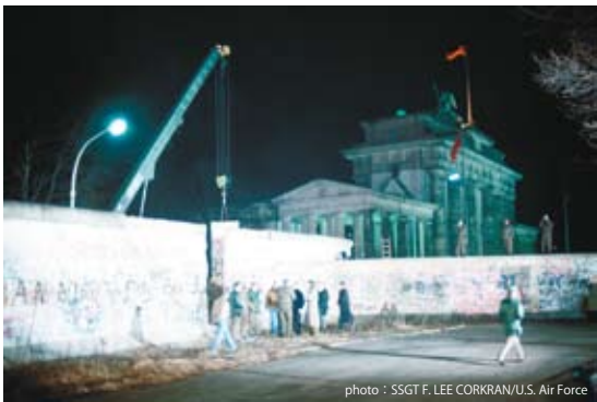
クレーンで分厚い壁を撤去する様子。その先に見えるのは、分断と統合の象徴「ブランデンブルク門」。
