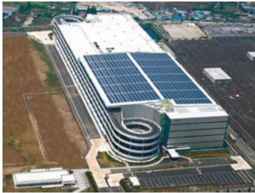
神奈川県にある大型物流施設「ブロッジスパーク座間Ⅰ」の屋上に設置された、物流施設としては国内最大級となる太陽光発電システム。5576枚(1MW)の太陽電池パネルが設置されている。
