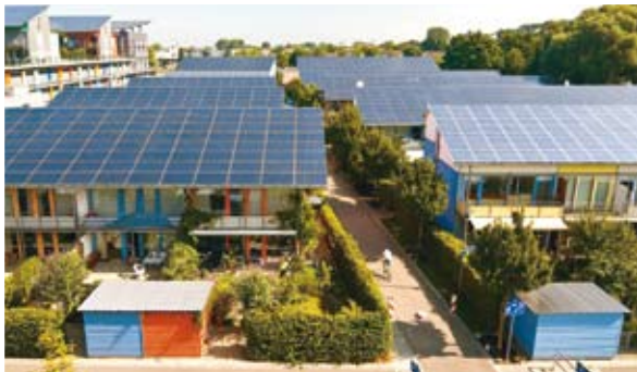
壁面を有効利用し、太陽電池パネルを設置しているビル。メガソーラーばかりが目されるが、一般家庭の屋根への太陽電池パネル設置も、ドイツでは多く見られる。
