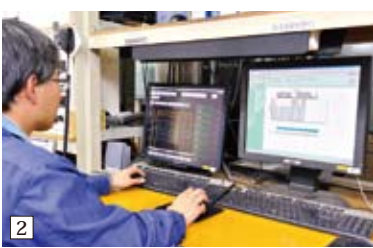
1 動力室に設置されたU-OPTの監視制御端末。 2 並べて設置されているHarmonasとEneSCOPEの監視端末。エネルギーの使用状況を確認しながら、設備の運転状況も把握できる。 3 動力室内の大型ディスプレイにはU-OPTやEneSCOPE、Harmonasの画面を表示することができ、運転員間での情報共有を行っている。
