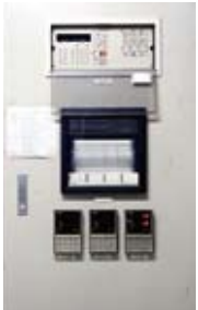
既存設備である熱源管理用デジタルコントローラPARAMATRIX™.IIを有効活用して新システムへ接続。ホッキョクグマ、ラッコ、ペンギンの部屋の空調を管理している。
