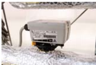
実験棟内のファンコイルユニットに設置されている電動弁 ACTIVAL™(アクティバル)。
