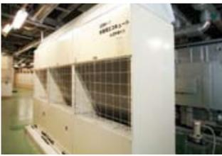
電気を利用してお湯をつくるエコキュート。従来のガスボイラーと併用して最適運用を行い、コスト削減に貢献している。
