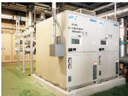
新設された下水再生水を利用するヒートポンプチラー。下水再生水を従来と比べて約2倍活用している。
