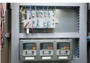
蓄熱槽の状態などを監視しながら、蓄熱槽の蓄熱/放熱切替えを行う汎用コントローラ Inflex™ GCと熱交換器の圧力制御を行うデジタル指示調節計 R36。
