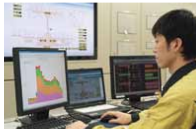
中央監視室に設置された建物管理システムsavic-net FX。
