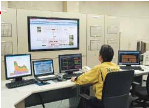
中央監視室に設置された建物管理システムsavic-net FX。
