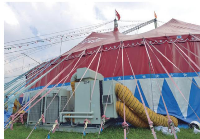
テントの外に設置された空調機。計6台で構成されている。
