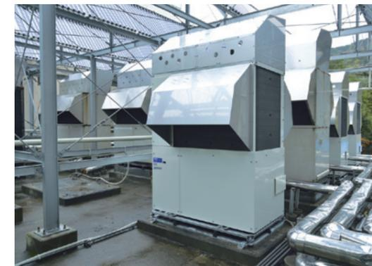
屋上に設置されたガスヒートポンプ(室外機)。
