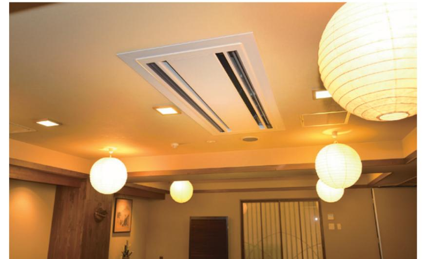
更新を行った室内機。旧室内機の開口部より新室内機が小さいので化粧板を入れて処理している。また、内装のクロス張替えも含めてアズビル金門エンジニアリングがトータルなサービスを提供している。
