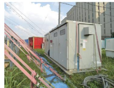
テント脇に設置された仮設受変電設備。ケーブルドラムに巻かれた電源ケーブルを分電盤へ敷設し、空調機を動かす動力などとして利用。この作業もアズビルが担当している。
