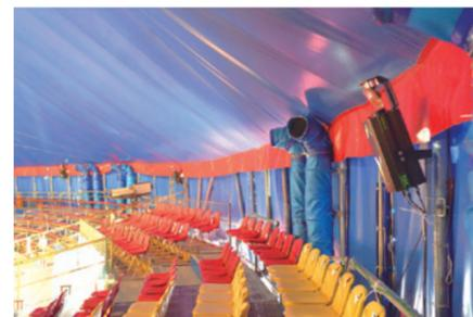
客席最上段部に取り付けられた給気用の吹き出し口。空調機1台当たり4本のダクトと吹き出し口で構成されており、6台分の計24カ所の吹き出し口から場内へ冷気が供給されている。
