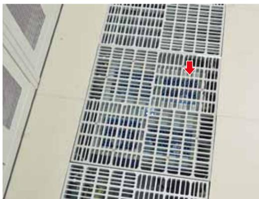
サーバールーム内の各所に設置されている床冷却ファン(グリルパネルの下)。その配置は、アズビルの熱気流シミュレーションに基づく分析により決定されており、二つのサーバールームに計34台のファンが設置されている。
