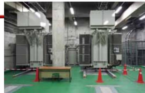
サンピアザとデュオで分かれていた受電系統を統合し、更新された特別高圧設備からデュオ側へ送電している。今回の工事で更新した特別高圧受電トランス7,500kVA×2台。
