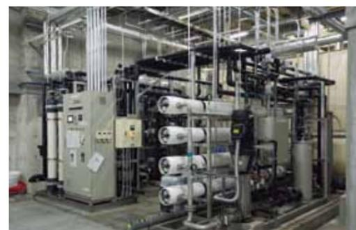
井戸水浄化システム。市の水道と同等の水質にして、飲食テナントを含む館内に供給している。水道光熱費の削減に大きく貢献している。
