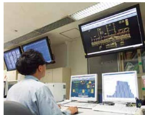
中央監視室に置かれたsavic-net FX。中央上部に設置された大型LCDを通じて、室内にいるすべてのオペレータが瞬時に情報を把握し、共有できる環境が整えられている。
