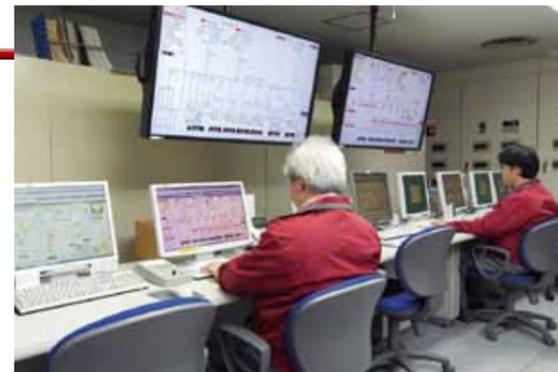
サンピアザの中央監視室に設置されたBEMSであるアズビルの建物管理システム savi-net™FX。デュオの中央監視室に置かれたBEMSとの間で相互監視が可能となっている。
