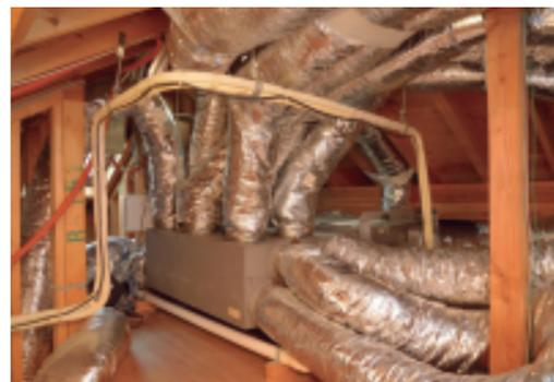
屋根裏に設置された室内機。ダクトなどはそのままに一部の機器だけを入れ替えるので、工事期間は短く抑えることができます。
