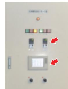
被膜設備の洗浄槽熱回収リモート盤。中央部の操作パネル SmartScreen で、熱回収にかかわる機器の運転状況などを監視・記録している。上部のデジタル指示調節計 形R35 ではドレン水のpH濃度を計測している。
