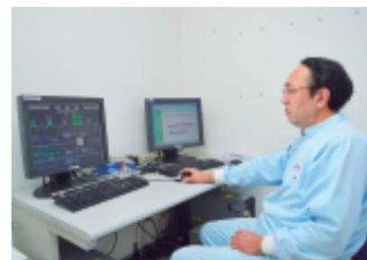
中央監視室に設置されたHarmonas(左)とEneSCOPE。Harmonasが製造ラインの機器の状態を監視し、EneSCOPEが電力使用量などの監視を行っている。
