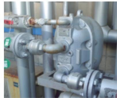
洗浄槽からオーバーフローした温水をくみ上げるためのパワートラップ。被膜工程で利用されている蒸気の一部によって駆動するため、防塵処理や電気式のような配線が不要であるなどのメリットをもたらしている。
