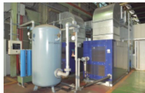
更新に合わせて工場内に分散して設置されていたコンプレッサを1カ所に集中設置した。老朽化を待たずに積極的に更新したことで、ランニングコストの早期削減も可能となった。
