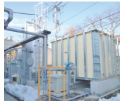
オーバーフロー水の浄化設備。洗浄槽からオーバーフローした温水は凝縮沈殿槽、pH調整、砂ろ過などの設備を経由して再び洗浄槽に戻される。
