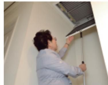
空気の吸込み口には電子式エアクリーナが設置されている。プレフィルタをメンテナンスするための開閉グリルは、開閉棒で開けるとゆっくと下降し、安全に掃除などの作業ができる。
