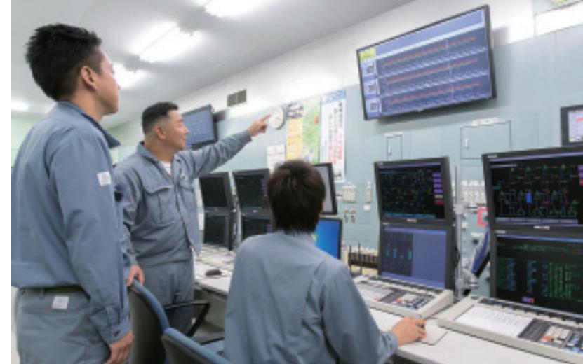
アノン製造プラントの集中監視を行う計器室。APS5000の監視・制御端末の上方には、65インチ大型モニターを設置。平常時にはAPS5000などの監視画面を表示し、警報発生時にはACTMoSの監視画面が強制表示される。警報が発せられた際には現場のメンバー全員が画面を見て状況を共有し、対処に向けた連携が取れるようになっている。
