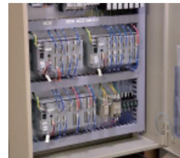
ポンプの台数制御を行う熱源管理用デジタルコントローラ PARAMATRIX™4と表示パネル。
