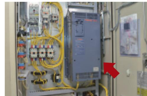
冷水ポンプの変流量制御に使われているインバータ。
