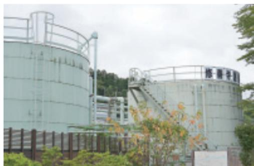
第一配湯所の貯湯槽。源泉からポンプで汲み上げられた湯が一定の水位で蓄えられており、ここから第二配湯所へと送り出される。2基(予備槽1基)構成。
