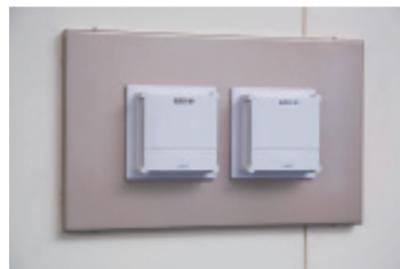
室内形温度/湿度センサ ネオセンサ™ワイヤレス。計測したデータを電波でRF受信機に伝送する。間仕切り変更などで設置場所を変えるときなども、大きな配線工事をすることなく移設が可能。
