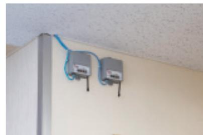
室内形温度/湿度センサ RF受信機。ネオセンサワイヤレスで計測したデータをRF受信機で受信。建物管理システムでモニタリングすることができる。
