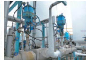
空気分離プロセスを支える低温バルブトップガイド形単座調節弁 HTS。マイナス190℃の液化酸素のコントロールを行う設備には超低温に耐えられる高度な耐久性が求められる。超低温の液体を扱っているため配管にも霜が付着している。
