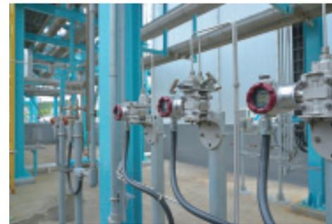
ガスの生産にかかわる空気分離プロセスに利用されている差圧・圧力発信器 AT9000 Advanced Transmitter SuperAce™。
