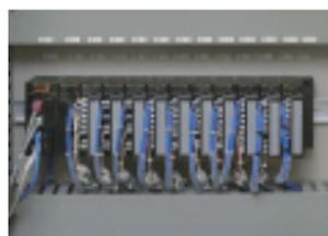
第一配湯所に設置された計装盤内にはインバータ制御に用いられる計装ネットワークモジュールNX、デジタル指示調節計SDCシリーズが組み込まれている。
