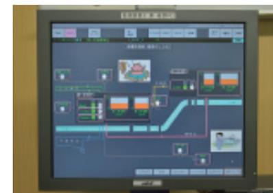
第一配湯所にある事務所に設置されたHarmonasの監視・制御端末。第二配湯所には、アズビルの提供するマルチクライアント環境TSSも併せて導入され、どちらの配湯所においても同じ画面を閲覧することができる。
