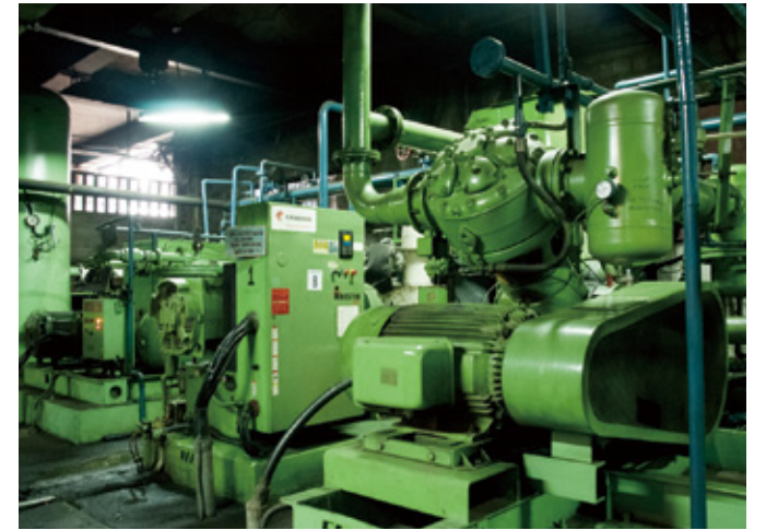
14台稼働している中のレシプロ式コンプレッサ。
