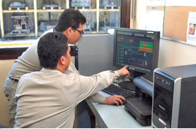
中央監視室に設置されたHarmonas-DEO。コンプレッサから製造現場に供給されるエアの消費量、圧力などの監視とそれに基づく機器の台数制御を行っている。
