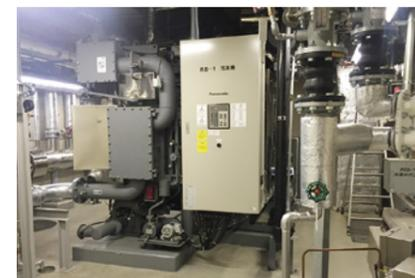
高効率熱源機と熱源管理用デジタルコントローラ PARAMATRIX™4を導入。最適運転制御により大幅な省エネルギーを図った。
