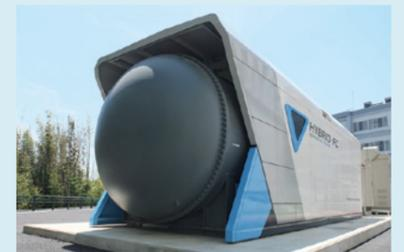
燃料電池の中でも、特に効率的に利用できる固体酸化物形燃料電池(SOFC)を完備し、研究を進めている。
