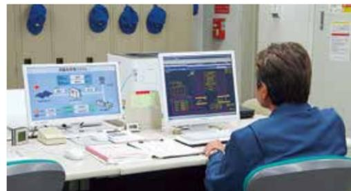
ライフパーク倉敷の中央監視室で稼働するsavic-net FX2と太陽光発電システム。建物内の設備の稼働状況に加え、エネルギー使用量などのデータ収集も可能となった。
