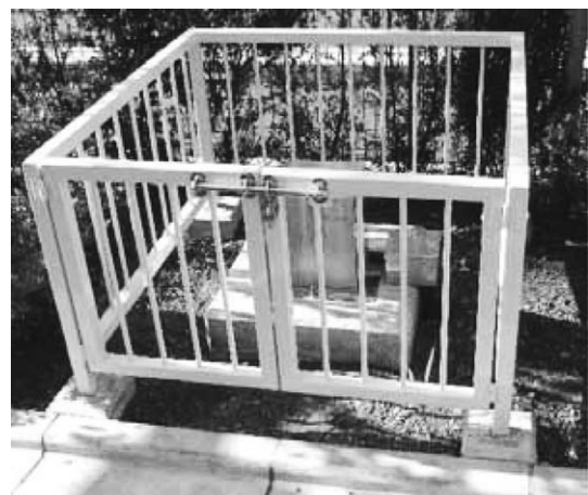
図8 SES60設置写真
