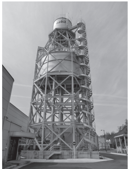
図 3. 高架水槽外観
