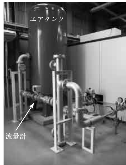
図6. 試験設備 (エアタンク)
