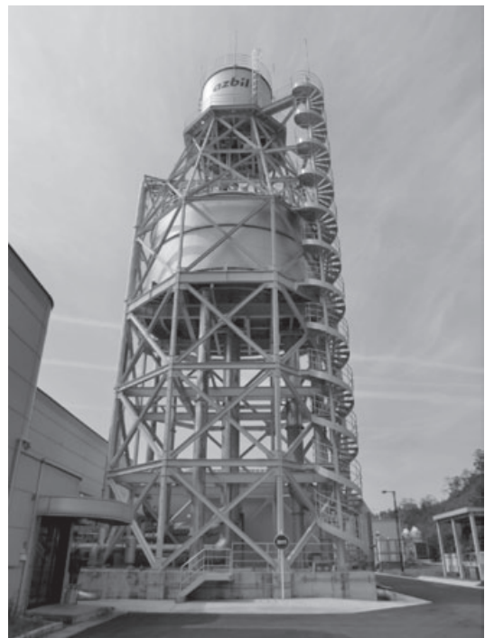
図 3. 高架水槽外観
